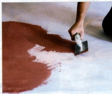
Esempi di rivestimenti ottenuti con la nuova tecnica Terre&Colors che viene realizzata con un composto a base di cementi finissimi, granulati minerali, cellulose e ossidi coloranti naturali, mescolato a uno specifico legante liquido, ad ottenere una miscela cremosa.
